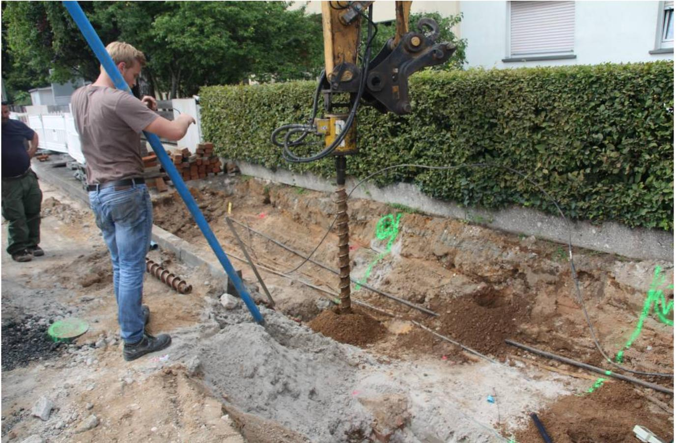
Diese Tiefensondierung wurde von der ausführenden, zuständigen Behörde für Bundesstraßen HessenMobil angeordnet, um eventuelle Risiken eines Bombenfundes auf 0 zu reduzieren. Im hier vorliegenden Fall wurde bei der Oberflächenmessung kein Bombenrichter entdeckt, aber aufgrund eines vorhandenen Kabelbaums konnte man nicht mit 100 % Gewissheit feststellen, dass sich unter diesem nicht möglicherweise doch ein Blindgänger befindet.
